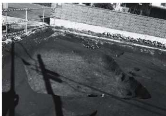
3区6号壑穴建物跡掘方全景(南より)
