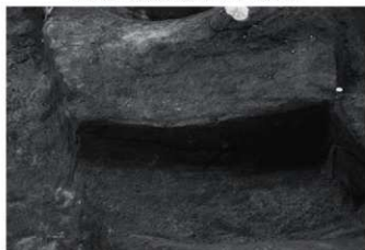
IV F区4号竖穴建物跡電跡堀方土層断面 A-A' (南・北)
