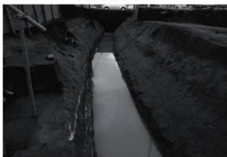
IV F区1号溝跡全景（西より）
