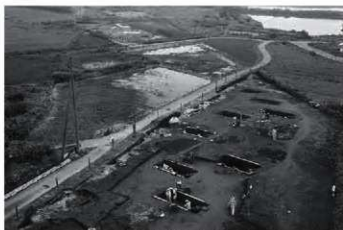
2. 2区作業風景 北上空から
