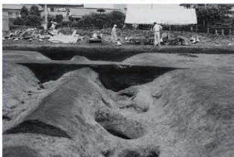
4. 4号溝中央部全景 南から
