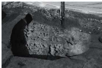
3. 38号住居跡掘り方全景 南から
