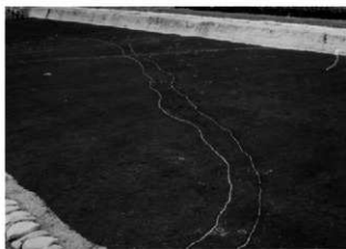
11区 1号畦状道橋
