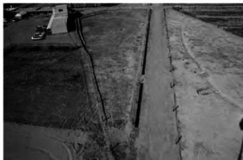
3 3c区全景(南から)
