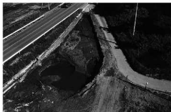
1 A区P9地点全景(南西から)
