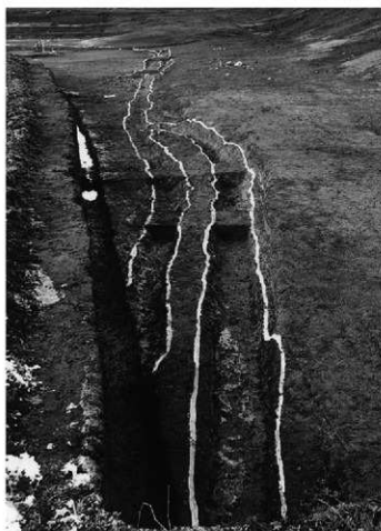
5 6号・7号溝全景(南から)
