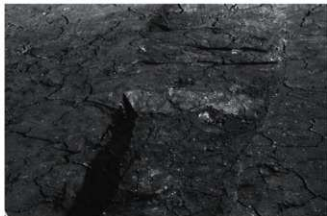
5区25号溝跡 断面(南より)
