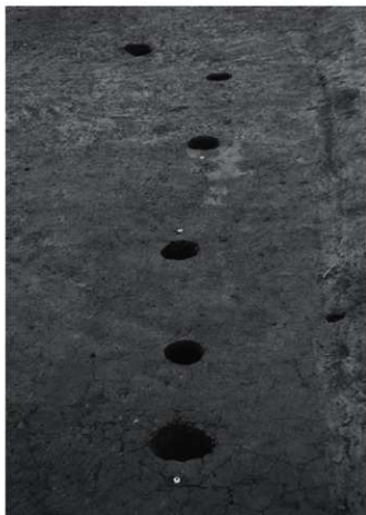
4区62・64～68号Pit跡 全景 (南より)
