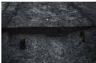
3区12号溝跡 断面 (南より)
