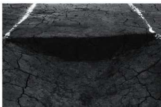
2区41号溝跡 断面 (南より)
