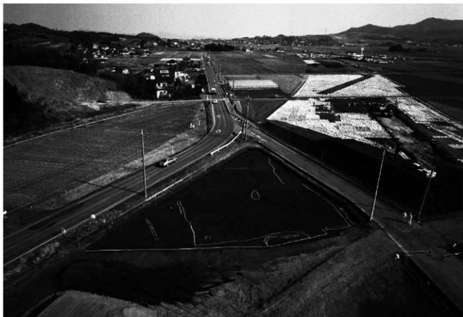
1区 全景 (西上空より)
