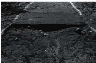
2区59号溝跡 断面A(北より)
