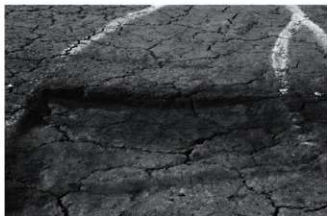
2区46号溝跡 断面 (東より)
