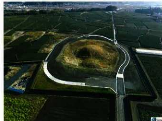
29 年度工事終了 西から
