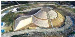
30年度工事完成 南から
