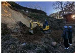
復旧工事の様子
