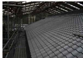
令和4年 葺き替えが完了した屋根
