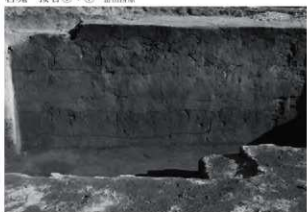
ローム層堆積状況 下段の暗い部分はATF褐色層 富田西原
