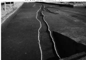
87号溝全景 (南西から)
