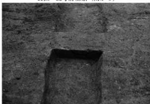
86号溝セクション (南西から)
