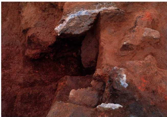
2区1号製鉄炉 炉体西壁（東から）
