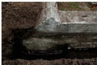
② 3号掩体壕第3トレンチ状況 袖部外側の掘方及び捨てコン状況
