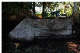
① 2号掩体壕第1トレンチ 左側手前袖部のコンクリート敷設状況と堀方ライン
