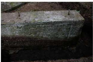
③ 3号掩体壕第3トレンチ状況 擁壁最下層の基礎打設と袖部基礎打設 での高低差の状況
