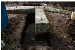
⑤ 3号掩体壕第3トレンチ状況 外側（前室・奥室変換点箇所）の掘り下げ完了
