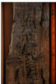
⑥ 同材の拡大写真 小屋内のステンシル銘入りの部材 「本熊木材株式会社」 「人吉第二工場」
