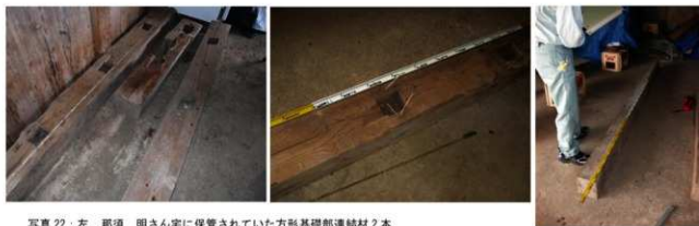
写真 23：中 長方形ほぞ穴を有するA材
