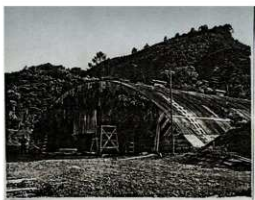
写真 68：左 木製格納庫事例(20m×20m規格) 立川航空機製造所疎開工場での施工例
