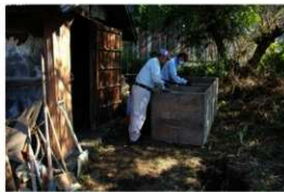
写真 48: 扉入れ大型ひつの解体作業
