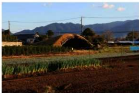
写真 76: 出水海軍航空隊 2号掩体の外観
