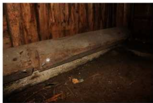
① 3号掩体壕柱材 小屋内の「ア材」の基礎部への設置状況
