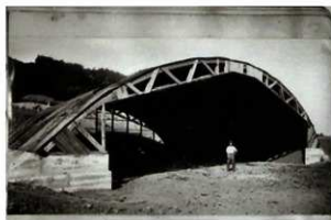
写真 68：左 木製格納庫事例(20m×20m規格) 立川航空機製造所疎開工場での施工例
