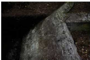
⑥ 3号掩体壕第3トレンチ状況 外側の掘り下げと外傾するコンクリート基礎 の状況
