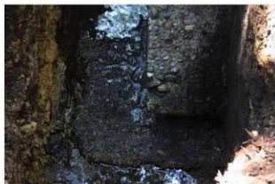
② 5号掩体壕第4トレンチ状況 斜方向に打設した捨てコン状況
