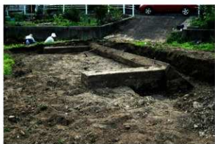
写真12: 3号掩体壕コンクリート
