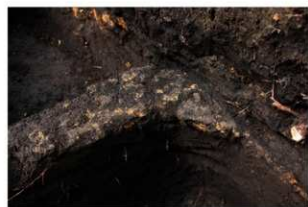
⑤ 4号掩体壕第5-2トレンチ状況 版築状の硬化面状況
