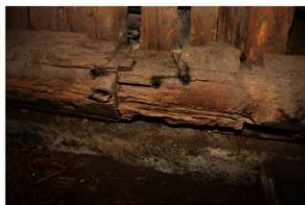
③ 3号掩体壕柱材 小屋内の「ア・イ両材」の仕口での結合状況
