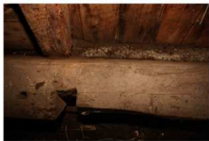
② 3号掩体壕柱材 小屋内の「イ材」での打ち欠き状況
