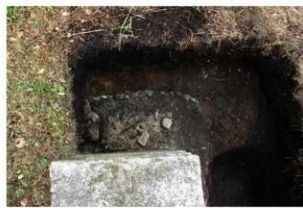
④ 3号掩体壕第3トレンチ状況 袖部の基礎設置状況と捨てコン状況
