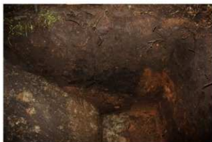
⑥ 3号掩体壕第5トレンチ状況 擁壁基礎部外側の状況と捨てコン状況
