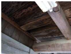
写真21: 納屋の床板に利用された梁材
