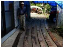
写真32:左 C材を用いての梁材復元の様子
