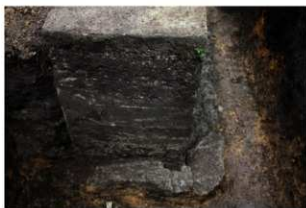
② 4号掩体壕第3トレンチ状況 打設時の垂木差し込み痕跡
