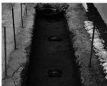
3. IV-4区3~5号礎石全景(南東)
