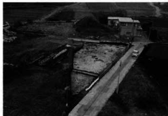
Ⅱ区 1面FP上 調査区全景 西から
