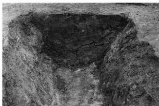
6号溝断面 (南東から)
