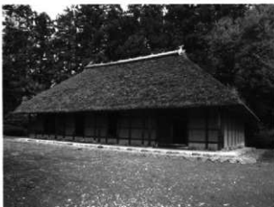
写真1. 旧阿久沢家住宅（群馬県前橋市柏倉町） [17世紀末期建造。平屋建・寄棟造・茅葺。桁行15.3m・梁行8.2mで、2号建物と同規模である。] （前橋市教育委員会の許可を得て掲載。橋崎撮影）
