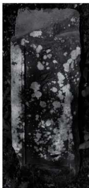
第 27 号石塔正面 (東から)
