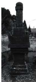
寺尾野宝篋印塔 (1378年) 基礎六段一石形成 塔身上二段段形 馬耳状三弧隅飾り 定型化
