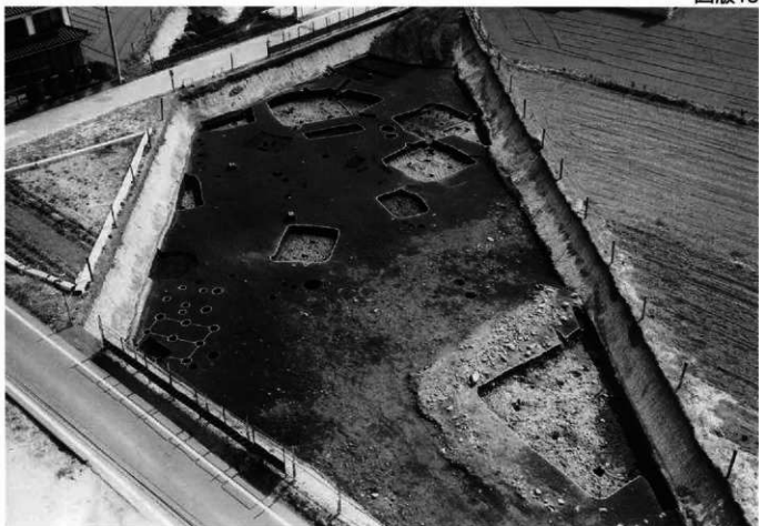
Ⅲ区 ローム上面全景
