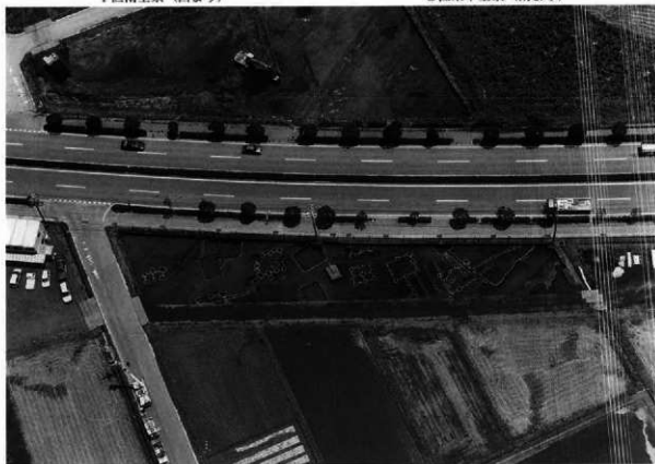
3区西半全景 (空撮)
