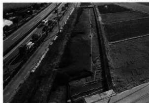
3区東半上面全景 (北より)
