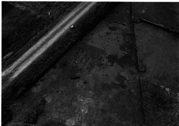
6区全景 (西より)
