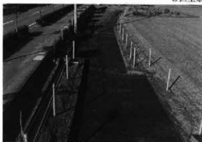
16区全景 (南より)
