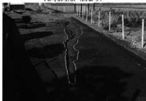
84号溝全景 (南西より)
