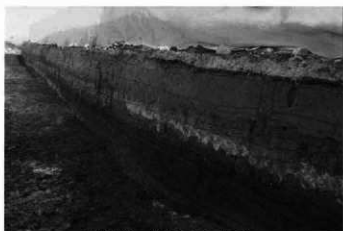
1区南壁 土層断面 (←北西)
