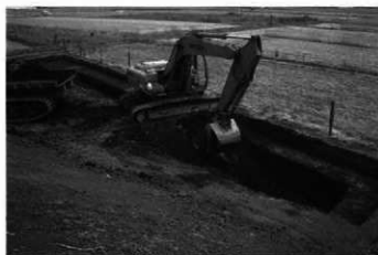
II区河道南端 調査風景 (←北西)
