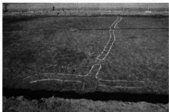
3区As-B下面基礎 全景 (←南)
