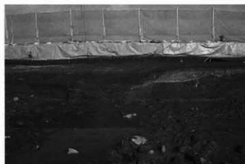
2区河道群 土層断面 (←南)
