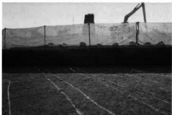
1区古代洪水層下水田 畦畔 (←南)
