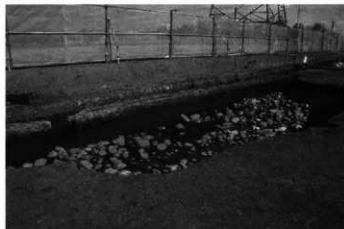
3区1号河道 土層断面 (←南西)
