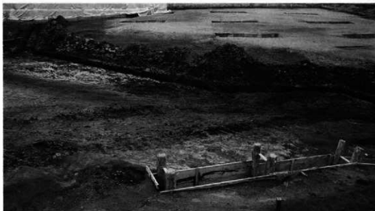
1 1区谷地部縦断トレンチ (B1-B5) 設定状況 (南から)
