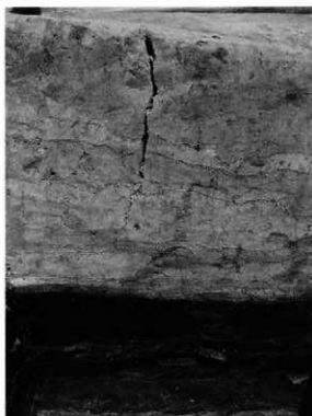
5 1区3-41-C-19グリッドルーム層土層断面(東から)
