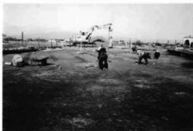
I区2面作業風景 (南より)
