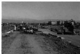
工事中の鮎川藤ノ木遺跡 (南より)
