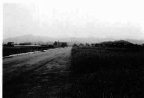
竣工後の上大塚南原遺跡 (北より)
