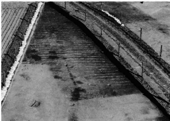
As-A復旧溝群(南より)
