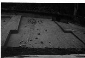
3号ブロック全景
