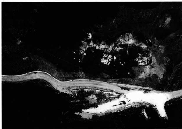
1. 17区二次調査全景
