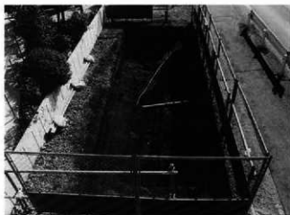
5区調査区全景 西→
