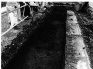
1区1号住居工事立ち会い時調査状況 西→
