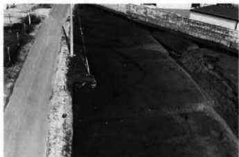
5 A区23号溝全景(南から)
