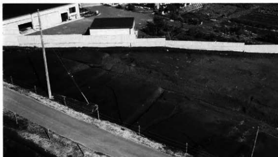
2 A区北半部分全景(西から)
