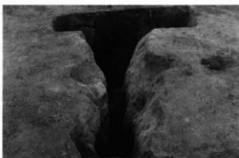
6 C区地割れ土層断面(西から)
