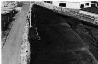
1 A区18~22号溝全景(南から)
