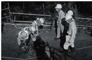
写真2 現地での安全確認作業
