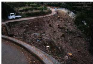
1 西浦足保林石丁場遺跡 掘削前状況（東から）
