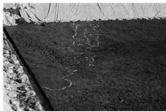
II区攪乱溝 (北西から)
