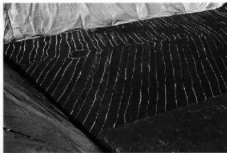
Ⅲ区11面南部 (南東から)
