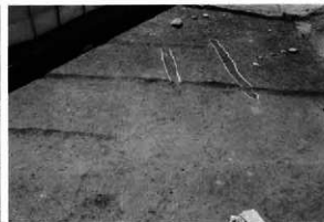
新島2区3面畑跡全景 北
