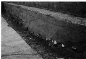
矢部5区深掘トレンチ西壁 東
