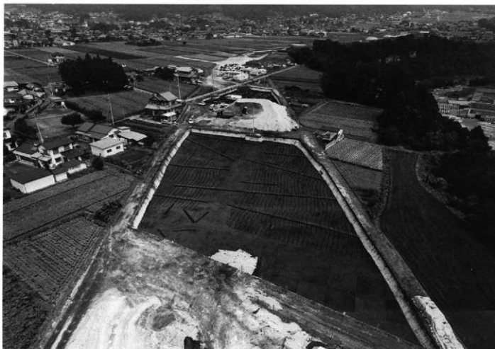
Ⅲ区 全景（南から。調査区右手は高さ40mの量となり、利根川の河原へと落ちる。左手の林は稲荷神社で、上毛古墳総覧では長尾村14号墳とされFP上面の古墳の可能性ある。）
