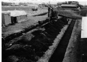
2 60区 (no49) 調査状況
