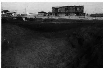
周堀断面 (A-A'、南から)
