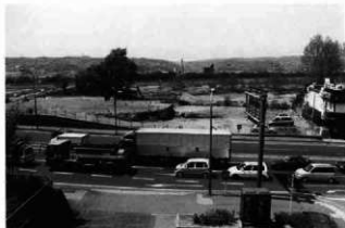
1区調査前全景 (東から)
