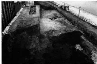
【和田城櫓台跡】石列確認状態（北から）
