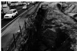
1号 (本丸西側) 堀全景 (北から)
