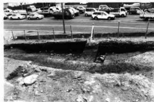
1号 (本丸西側) 堀上層全景 (西から)
