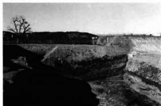
2・3号堀土層断面 右上には堀跡の凹みが擁壁となって残る
