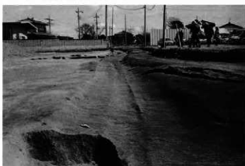
8 現道と重なって見つかった3区道跡 (西から)
