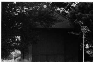
諏訪神社解体直前 東から
