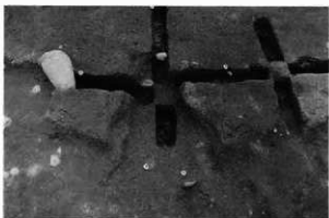
住137電使用面状態 北西から
