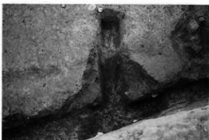
住120電使用面状態 西から
