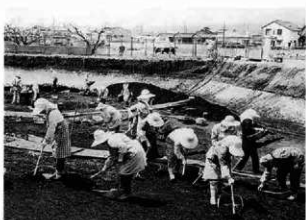
Ⅲ-1区 作業風景
