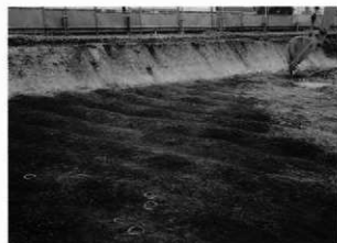
Ⅲ-1区 Hr-FPF 畜跡
