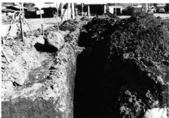
4 I区西側トレンチ掘削状況（北から）
