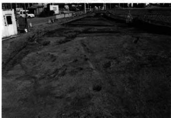
77 I区中・近世遺構検出状況(北から)
