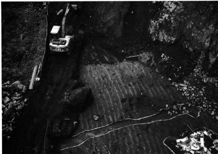
写真1. I区KA 2-4号畑 西→
