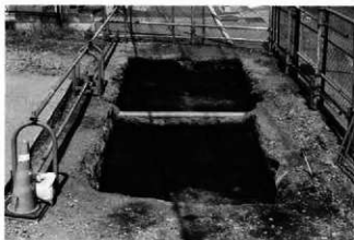
D-1区古墳時代～奈良平安時代面 全景 西から
