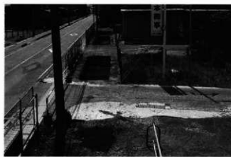
D-8～11区古墳時代～奈良平安時代面 全景 東から
