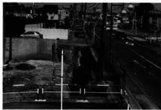
D-1～6区古墳時代～奈良平安時代面 全景 西から
