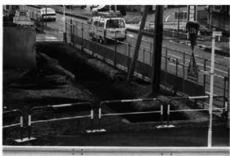
D-6区古墳時代～奈良平安時代面 全景 西から
