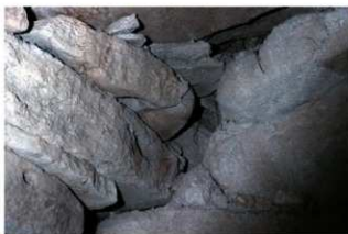
写真7 天井部付近の石積み
