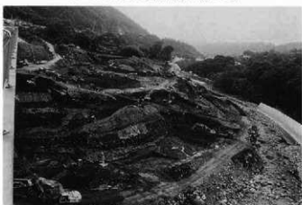
8. 調査後の工事風景 (南東から)
