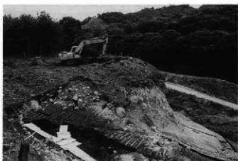
6. IXB区表土掘削風景 (東から)
