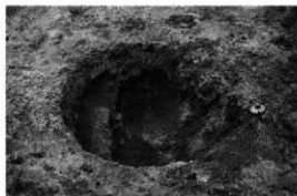
A区20ビット完掘状況
