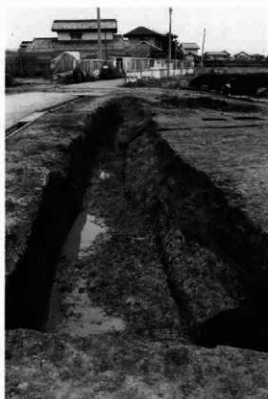
A区16号溝西岸部（北から）左は市道
