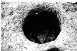
A区74ビット完掘状況
