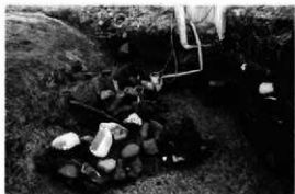
B区1号溝南端での崩れた石垣
