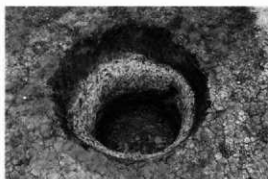
A区9号井完掘状况
