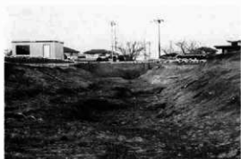
B区1号溝底面部分の状況
