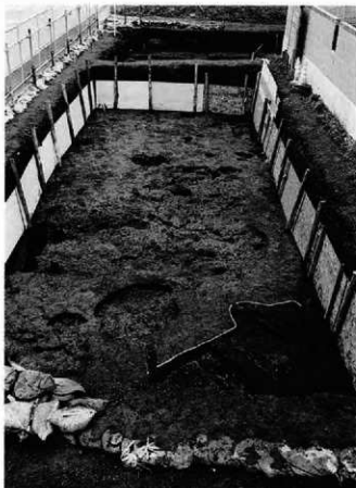
2. 0-1区西側全景 西から
