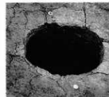
20. 39号ピット 南から
