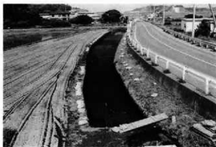
3区全景 西から撮影
