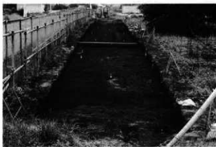
4区全景 西から撮影
