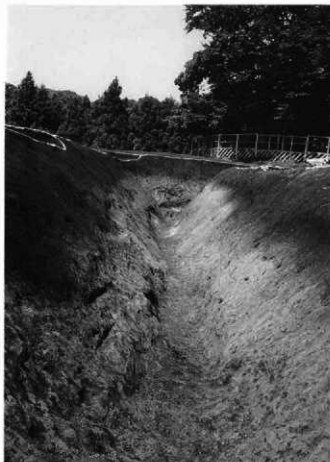
①中世2号堀陸橋西側完掘（東より）
