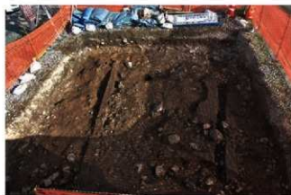
サブトレンチ掘削状況 南から
