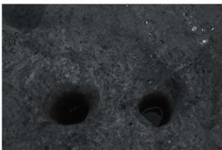
SK1内 (左) pit2 (右) pit1 西から
